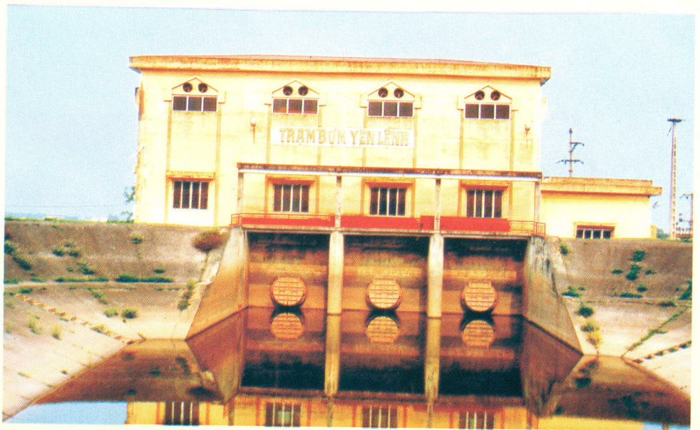
Trạm bơm Tiêu úng Yên Lệnh công suất 27000 m 3 /giờ xây dựng năm 1999
