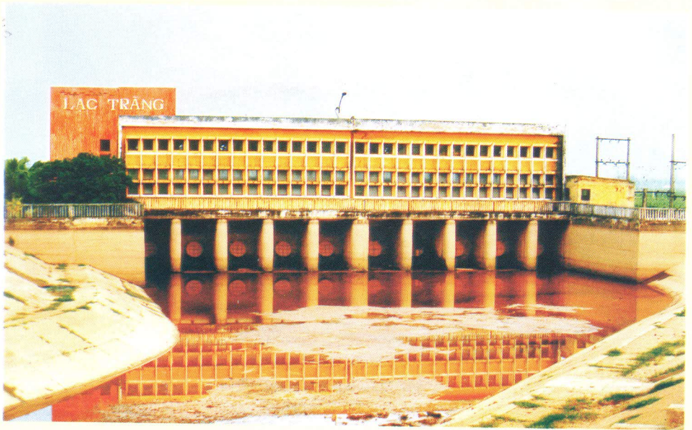
Trạm bơm điện Lạc Tràng xây dựng 1994, hàng năm đều được tôn tạo nâng cấp
